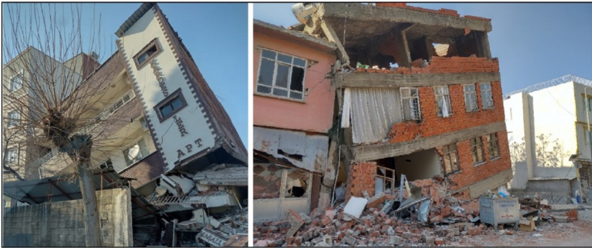
Figura 16. Colapso por volcamiento.
