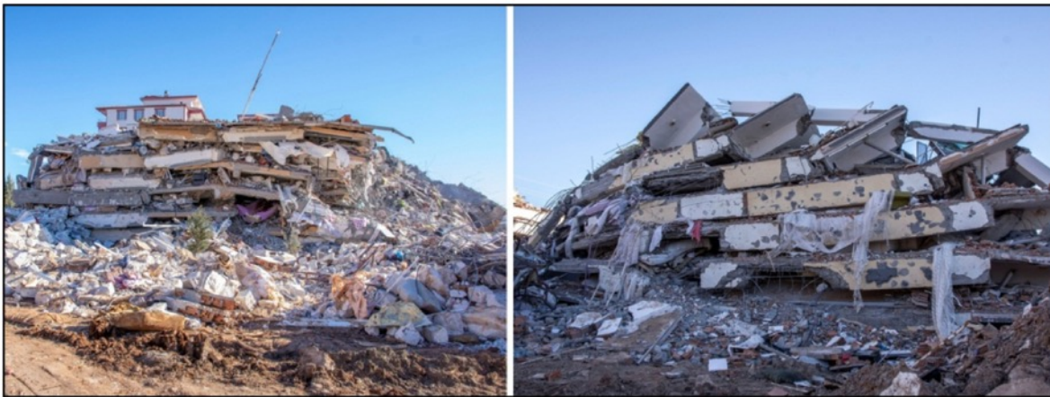
Figura 17. Colapso tipo "pancake" o apilamiento.
