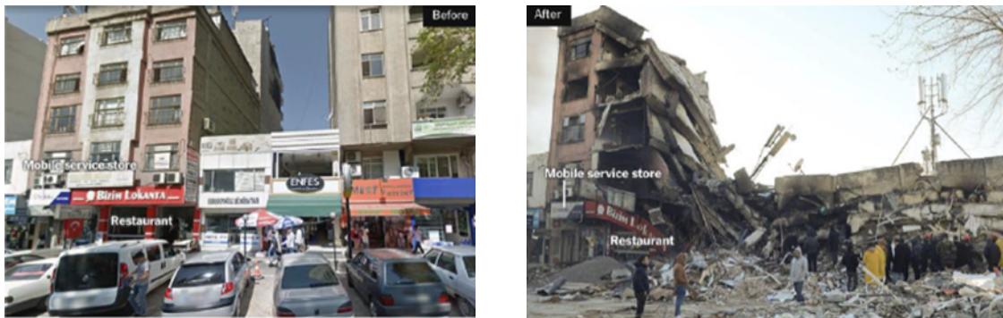
Figura 22. Colapso de edificaciones debido a pisos débiles o a golpeteo con edificios adyacentes. Izquierda: previo al evento; derecha: después del evento.
