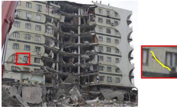
Figura 24. Edificio parcialmente colapsado. Se observan fisuras diagonales significativas en la estructura.
