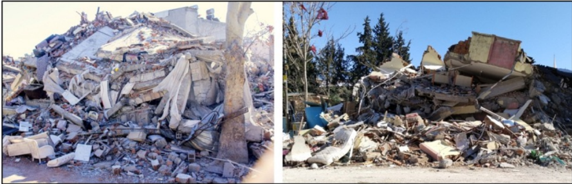
Figura 18. Colapso con amontonamiento de escombros.
