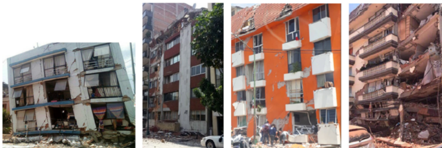
Figura 8. Falla por piso débil en el primer piso de edificaciones durante el sismo de México del 19 de septiembre de 2017. Tomado de Jara et al. (2020).
