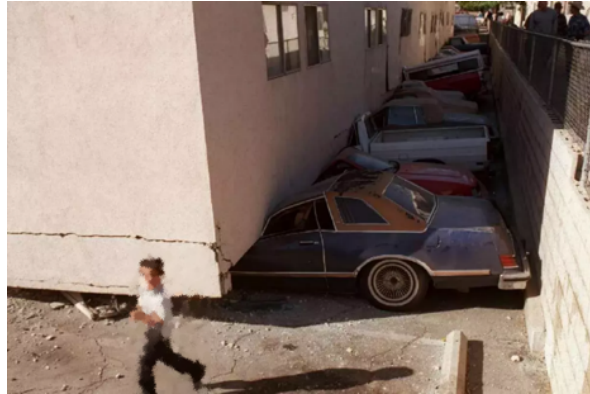
Figura 7. Falla por piso débil observada en el terremoto de Northridge, 1984. Tomado de Los Ángeles Times (2023).
