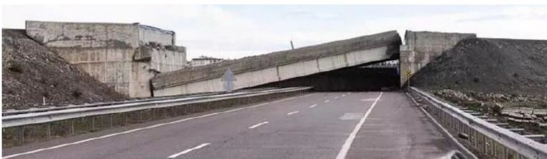
Figura 27. Fallo por desasiento en puentes.
