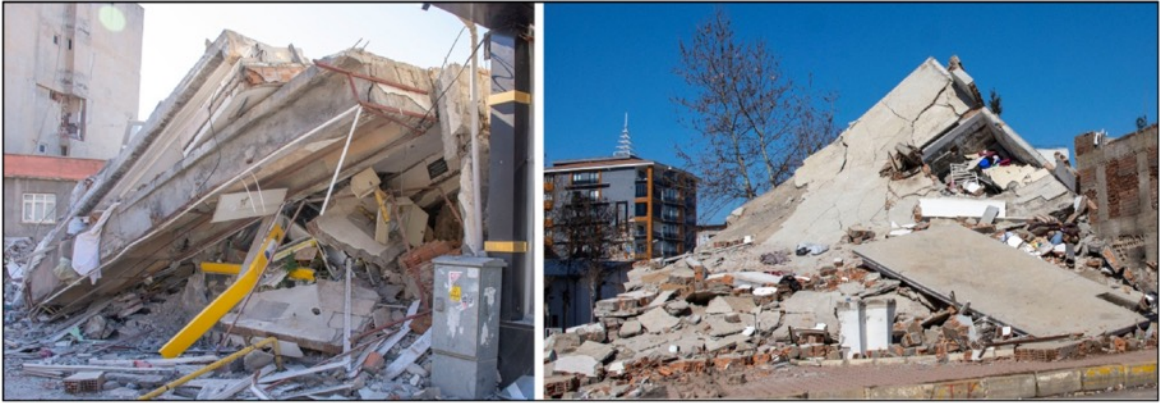
Figura 15. Colapso tipo inclinado.
